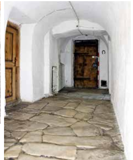
Abb. 4 Labe im Erdgeschoss mit ausgelegten Marmorplatten
