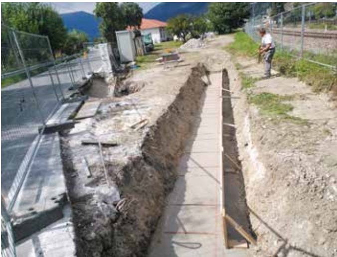
Umbau "Dreisnitz" zur "Laaser Marmorwelt" 2014
