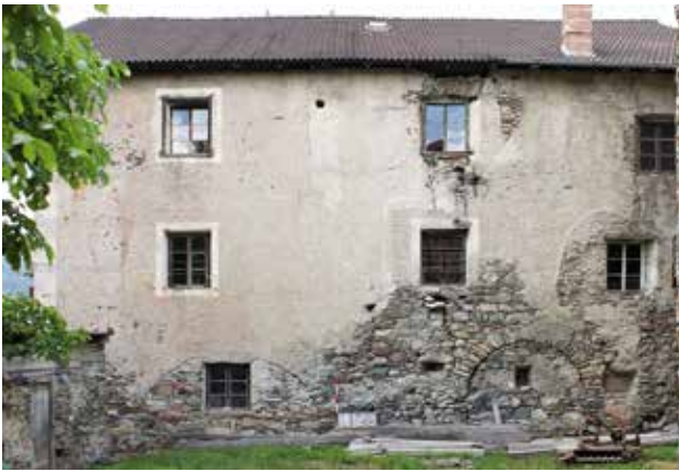
Abb. 2 Ostfassade mit abgemauerten Bogenstellungen im Kellergeschoss
