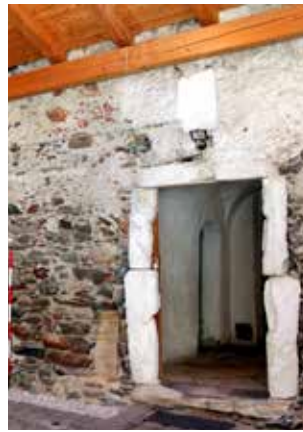
Abb. 3 Portal aus Marmorwerksteinen am bergseitigen Zugang zum Erdgeschoss
