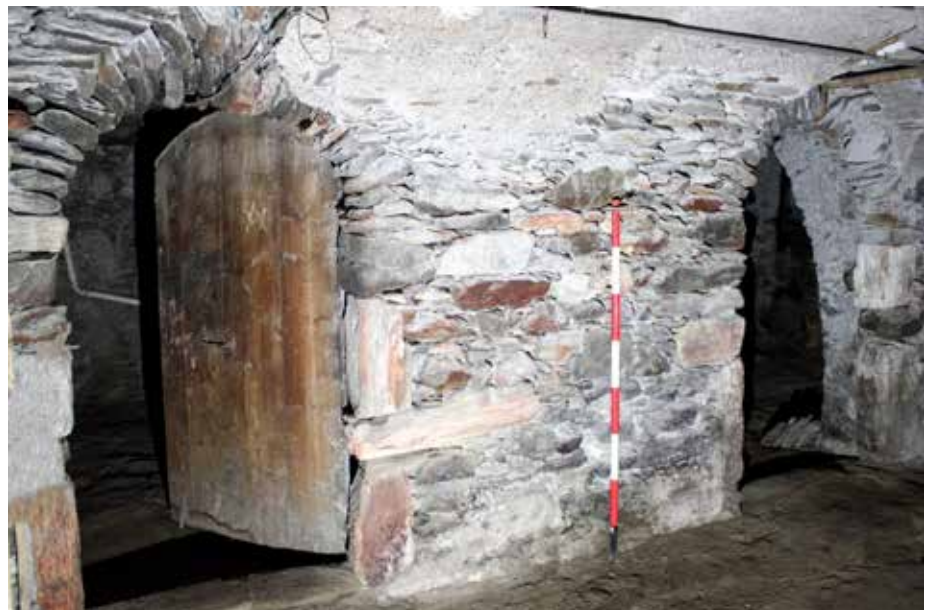
Abb. 5 An den Kellerzugängen sind Werksteine aus Marmor verbaut
