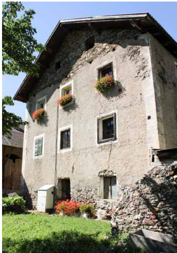
Abb. 1 Südfassade mit aufgemauertem Giebel nach dem Dorfbrand von 1861. Alle Fotos Martin Laimer 2022
