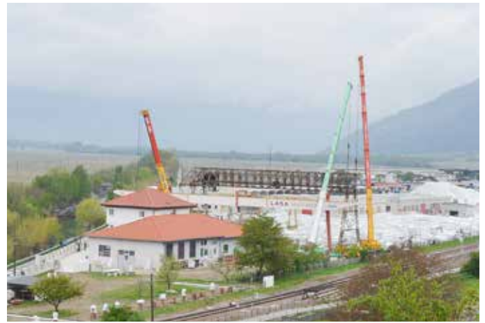
Verstellen vom historischen Portalkran 2015
