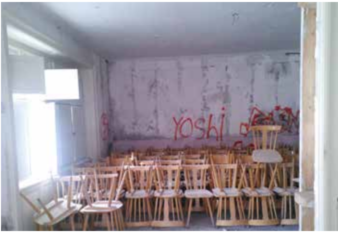
Umbau Bahnhof zum Filmvorführungsraum 2013
